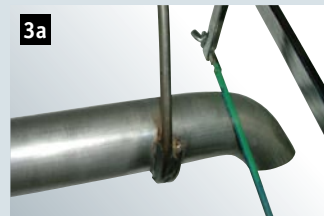
3a Rohrbogen entweder mit einer Säge oder mit einer Flex abtrennen.
